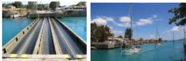
شکل ۱۱. تصویر راست: پل یونان در حالت باز، تصویر چپ: پل یونان در حالت بسته (structurae.net)
