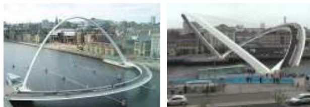
شکل ۱۴. تصویر راست: پل هزاره در حالت باز، تصویر چپ: پل هزاره در حالت بسته (structurae.net)
