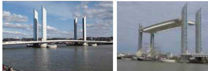
شکل ۱۰. تصویر راست: پل ژاک چبان در حالت باز، تصویر چپ: پل در حالت بسته (hardestyhanover.com)
