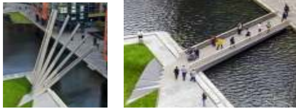
شکل ۸ راست: پل بادبزی انگلستان در حالت بسته، چپ: پل بادبزی در حالت باز (Golabchi & Alaghemandan, 2010).
