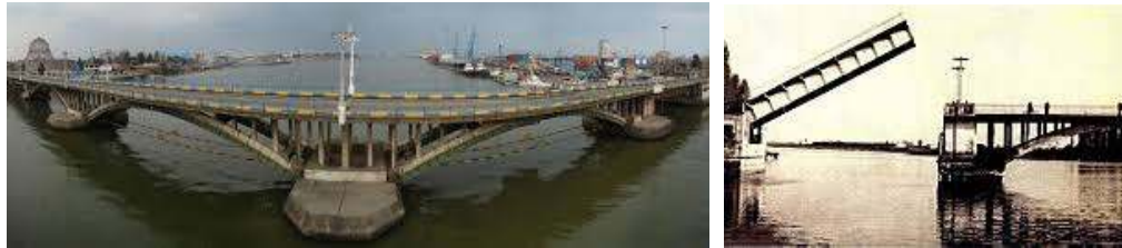
شکل ۹. تصویر راست: پل غازیان در حالت باز، تصویر چپ: پل در حالت بسته (Mokhlesi, 2000)
