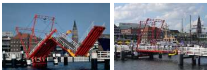
شکل ۱۶. تصویر راست: پل هورن در حالت بسته، تصویر چپ: پل در حالت نیمه باز (Golabchi & Alaghemandan, 2010)
