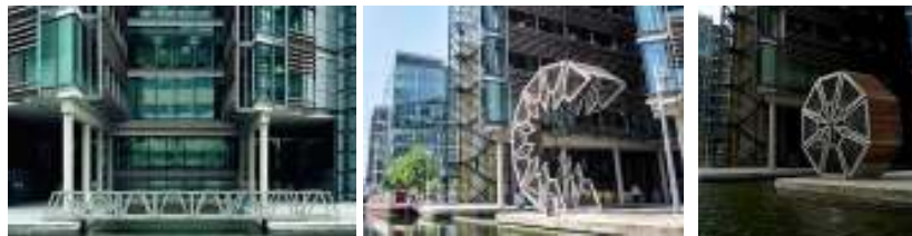
شکل ۱۵. راست: پل غلتان در حالت باز، میانی: پل در حالت نیمه باز، چپ: پل در حالت بسته (Zhang et al., 2019)
