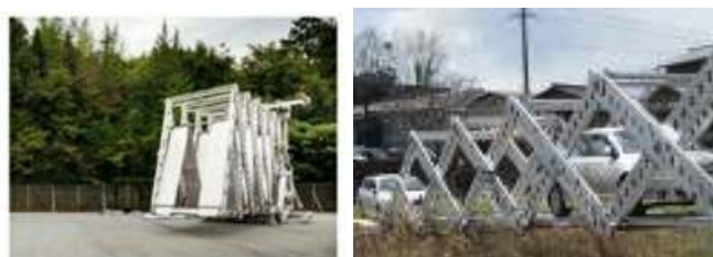
شکل ۱۷. تصویر راست: پل قیچی‌سان در حالت بسته، تصویر چپ: پل در حالت باز (steelconstruction.info)
