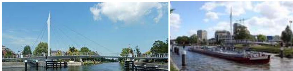
شکل ۱۳. تصویر راست: پل ریجسویج در حالت باز، تصویر چپ: پل در حالت بسته (wikipedia.com)
