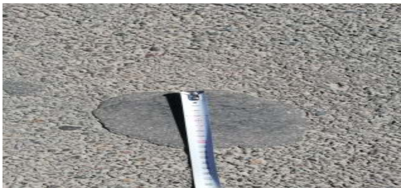
شکل ۸. نمونه‌ای از قیر زدگی
