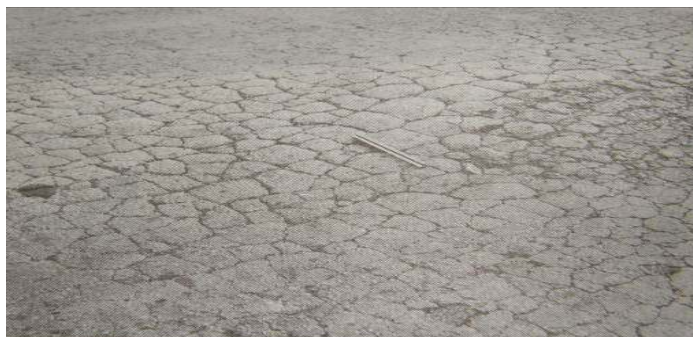
شکل ۲. نمونه‌ای از ترک‌های پوست سوسماری
