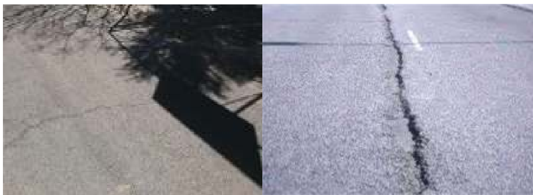
شکل ۳. نمونه‌ای از ترک‌های طولی و عرضی
