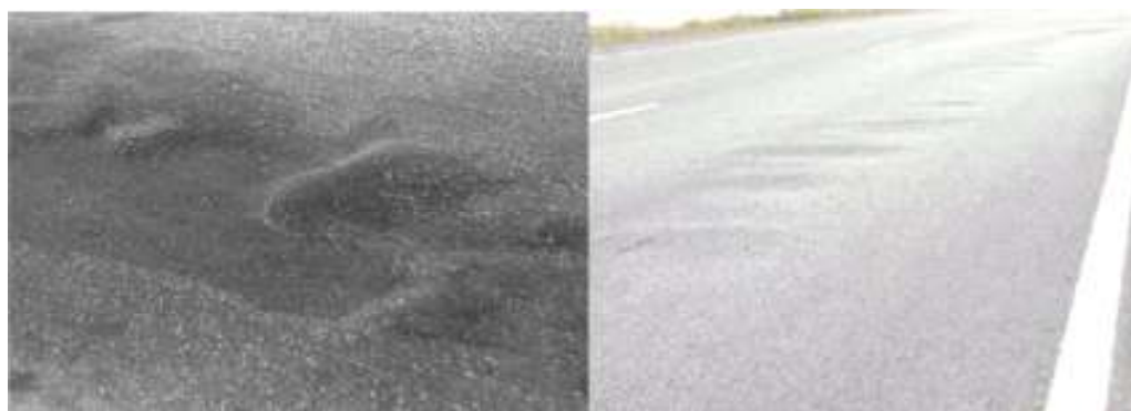
شکل ۵. نمونه‌ای از خرابی موج زدگی
