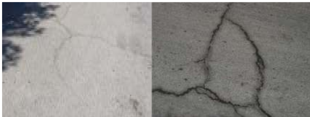
شکل ۱. نمونه‌ای از ترک‌های بلوکی
