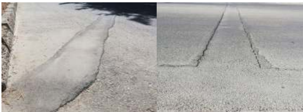
شکل ۷. نمونه‌ای از وصله کاری
