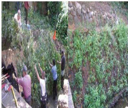
شکل ۵. لایه لایه قرار دادن قلمه‌ها
