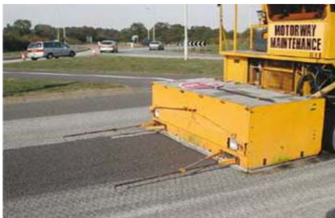
شکل ۱. مقایسه بین رویه قبل و بعد از چکشی کردن
