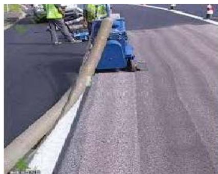
شکل ۳. مقایسه بین رویه قبل و بعد از شات بلاست کردن
