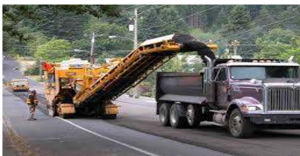
شکل ۷. ماشین احیا سازی رویه صیقل یافته به روش تراش سرد
