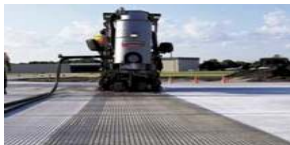
شکل ۹. شیار بارانی بر سطح رویه بتنی با روش شیار زنی
