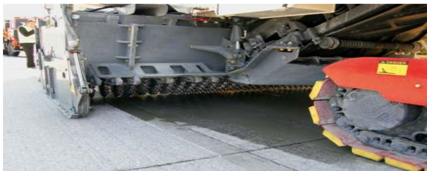
شکل ۸ ماشین احیا سازی رویه صیقل یافته به روش از طریق روش تراش نرم
