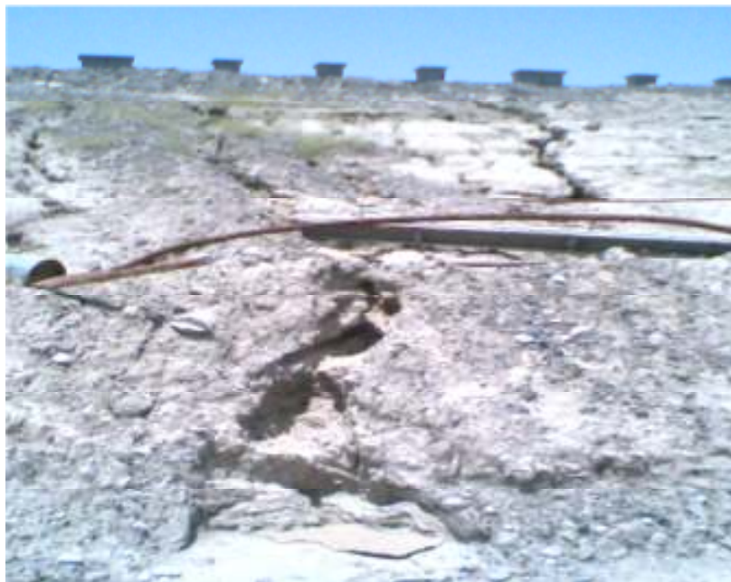
شکل ۱. حفرات ایجاد شده ناشی از واگرایی خاک در پشت سد میناب
