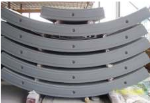
شکل ۴. انبار کردن سگمنت‌ها
