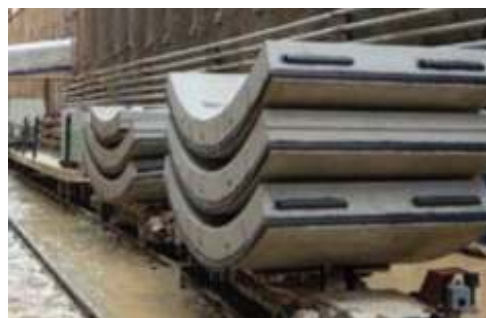
شکل ۶. جابجایی سگمنت‌ها
