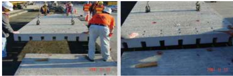
شکل ۲. نحوه استقرار دال بتنی در روسازی بتنی پیش ساخته درز دار (Tayabji و همکاران، ۲۰۱۳)
