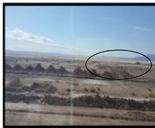
شکل ۳. اجرای شمع پیچی در بستر راه‌هایی با خاک مسئله‌دار
