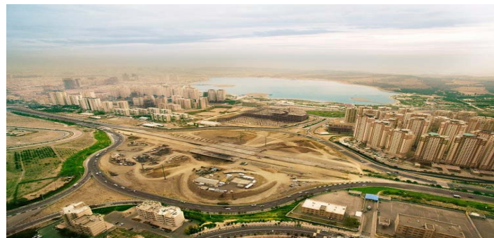
شکل ۶. پروژه احداث زیرگذر بلوار دریاچه
