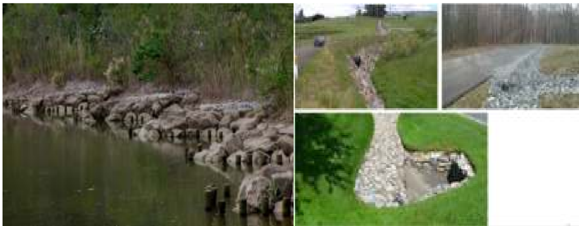
شکل ۱۴. نمونه استفاده از ریپ رپ در کشورهای مختلف (JICA,2018)
