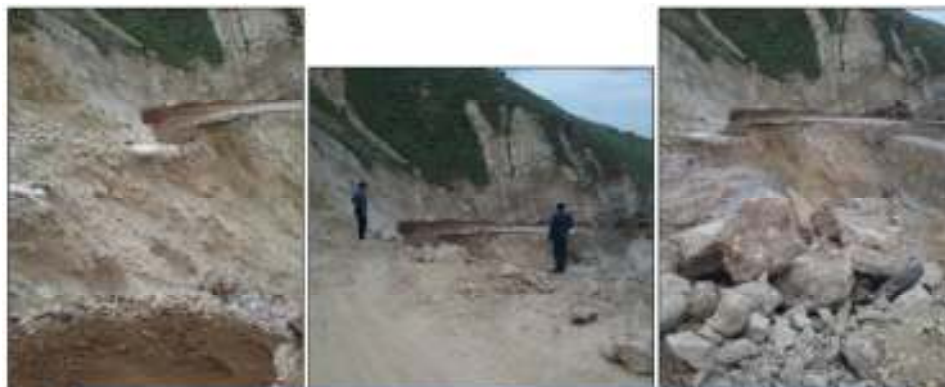
شکل ۳. ریزش خاک و توده‌های سنگ تخریب کامل یا بخشی از بدنه جاده - انسداد مسیر سیل ۹۸ استان (گ-۸۴۷-۰۴، ۱۳۹۸)
