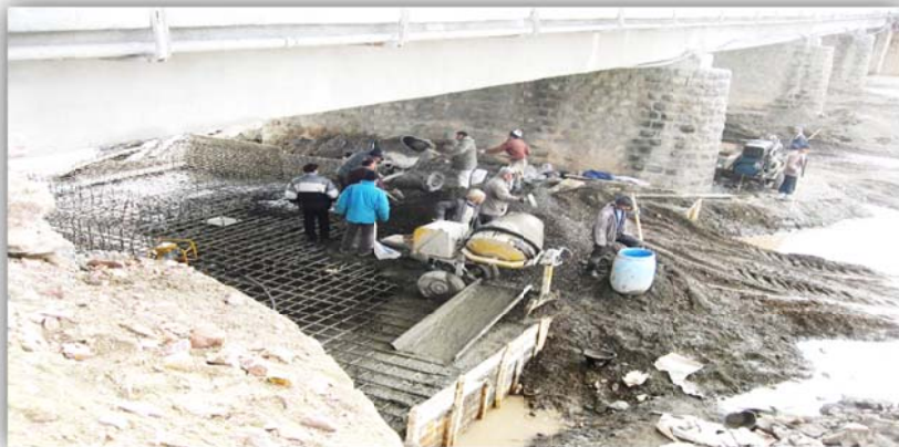
شکل ۱۵. آرماتور بندی و احداث رادیه
