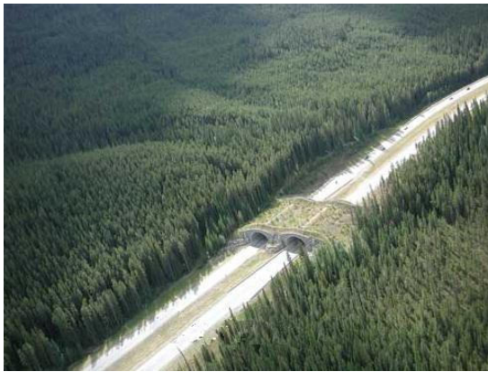
شکل ۱۰. پل سبز در بزرگراه پارک ملی بنف در کانادا
