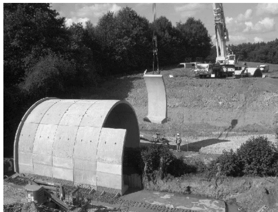
شکل 9. احداث زیرگذر جانوران در بزرگراه‌های انگلستان
