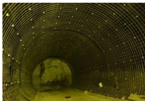
شکل 12. قالب لاینینگ تونل
