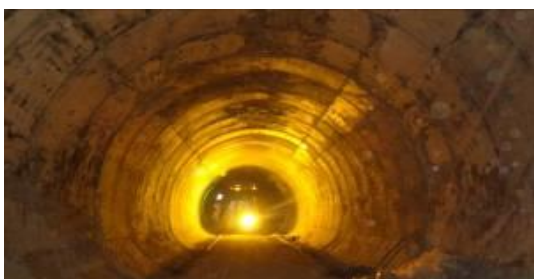
شکل 14. نمایی از تونل بعد از بتن ریزی لاینینگ
