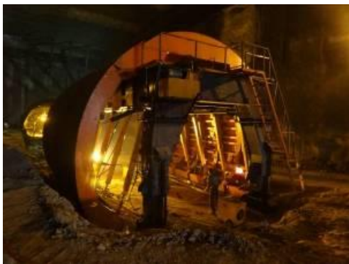
شکل 11. تکمیل آرماتوربندی لاینینگ
