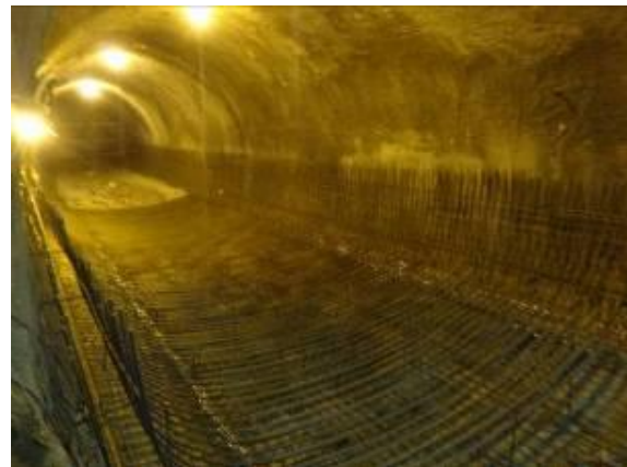
شکل 8. بتن ریزی رادیه کف تونل
