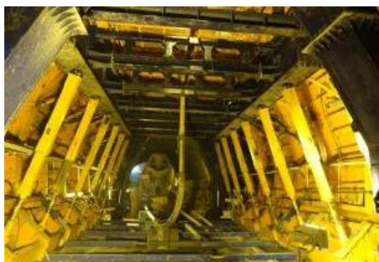
شکل 13. بتن ریزی لاینینگ
