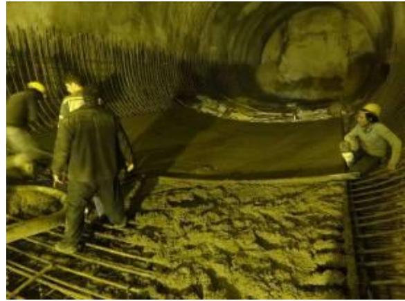
شکل 7. آرماتوربندی رادیه کف تونل
