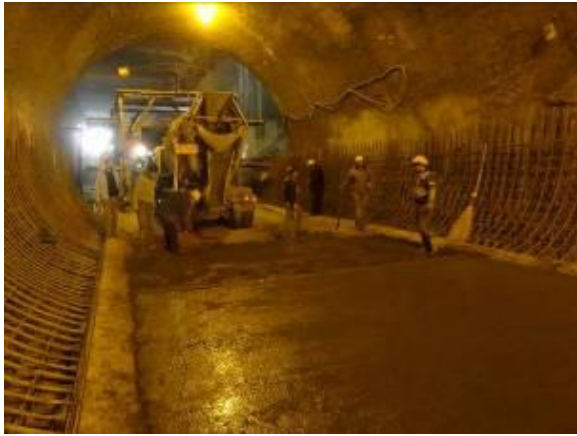
شکل 9. بتن ریزی روی رادیه کف برای زیر ریل قالب لاینینگ
