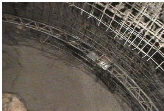
شکل 6. اجرای نگهداری اولیه شامل مش و شاتکریت و قاب لتیس گیردر
