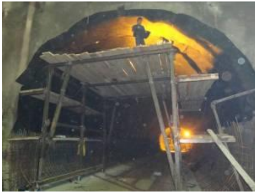
شکل 10. نصب عایق ژئوممبران قبل از آرماتوربندی سقف
