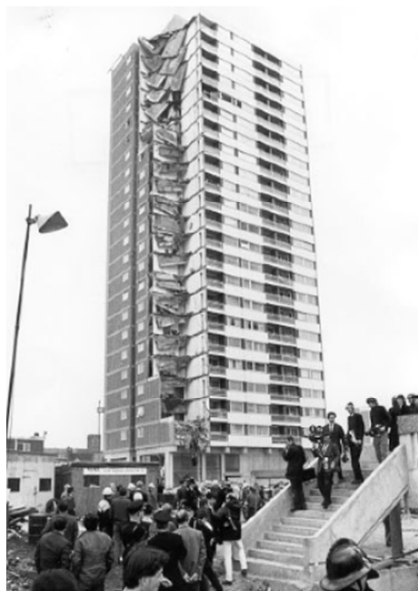
شکل ۶. خرابی ساختمان رونان پوینت (ساعدی، ا، ۱۳۸۹)
