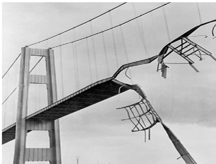
شکل ۵. خرابی به علت پارگی کابل و افزایش بار بر کابل‌های همسایه (ساعدی، ۱۳۸۹)
