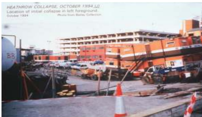
شکل ۲. خرابی های ناشی از گسیختگی تونل زیر محوطه فرودگاه Heathrow
