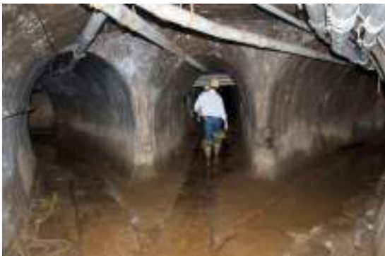
شکل ۱. خرابی های برجای مانده در نتیجه ورود سیل به تونل حمل بار شیکاگو
