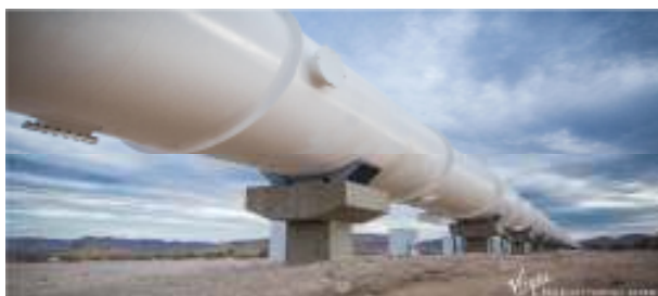
شکل ۷. نسب لوله بر روی پایه های مستحکم
