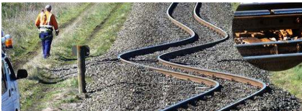
شکل ۹. انبساط حرارتی فولاد (ریل آهن)
