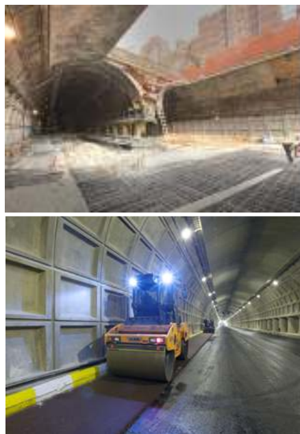
شکل ۶. روسازی ترکیبی بتنی و آسفالتی تونل توحید
