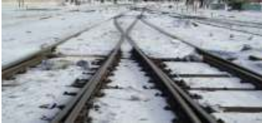
شکل ۲. یخزدگی سوزن در فصل سرد سال
