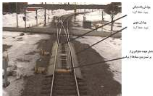
شکل ۱۳. انواع پوشش ها در سوزن (Kloov and Jenstav, 2011)
