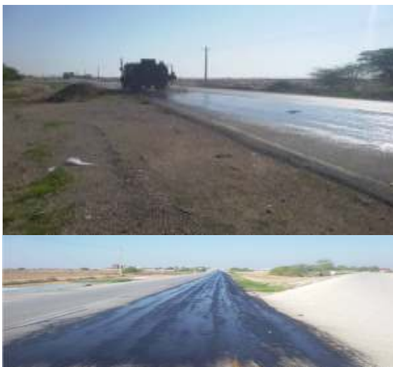
شکل ۱۶. مراحل اجرای فوگ سیل در باند عبوری محور خورموج-چغادک (حد فاصل سه راهی گادویی تا چغادک)
