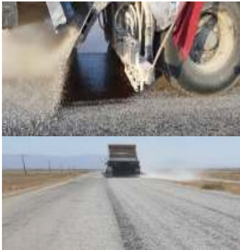
شکل ۱۴. مراحل اجرای چپ سیل در باند عبوری محور چغادک-خورموخ (حد فاصل روستای قباکلکی تا دمربادان)
