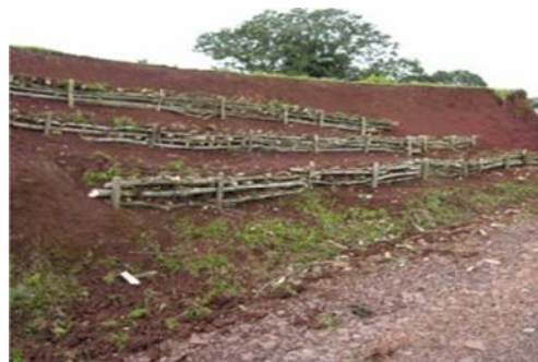
شکل ۱۲. دیواره بامبو Bambo Fancing
