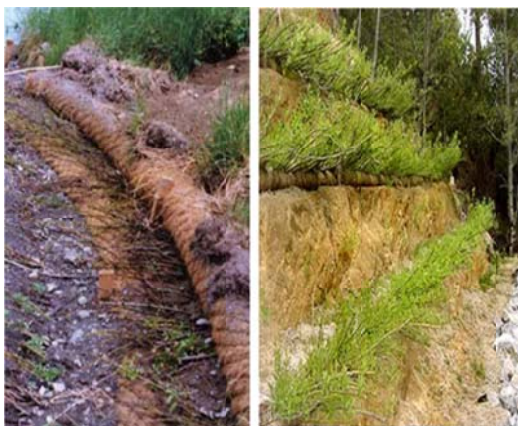
شکل ۶. تور جوت (شبکه کنفی)
