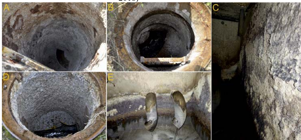
شکل ۱. نمونه‌هایی از علائم زوال معمول در سیستم‌های تحت تاثیر خوردگی بتن ناشی از میکروبی. تصاویر A، B و D در چاهک بازدید بتنی در مسیر شبکه قدرت گرفته شده اند، در حالی که تصاویر C و E آسیب‌های موجود در حوضه‌های آبریز فاضلاب را نشان می‌دهند. (Grenng et al., 2018).
