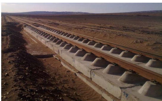
شکل ۳. طرح سه بعدی روسازی دال خط کوهاندار و نمونه‌ای از روسازی اجرا شده در ایستگاه نمکزار
