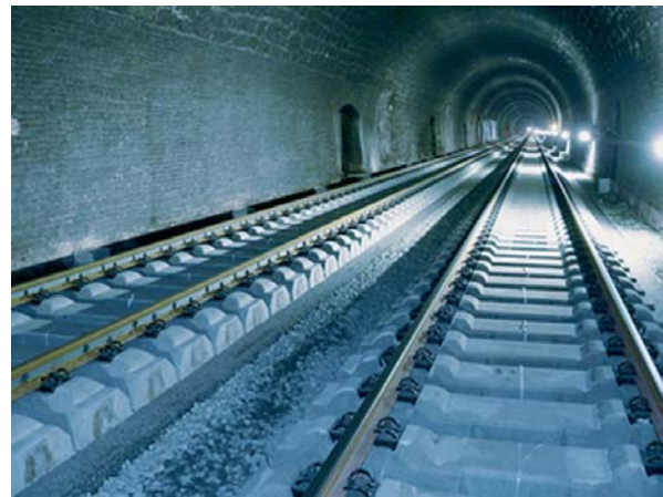
شکل ۱۵. خط گترک پس از تکمیل مراحل احداث (Esmaili, Mehrzad, Ghahari, 2016)
