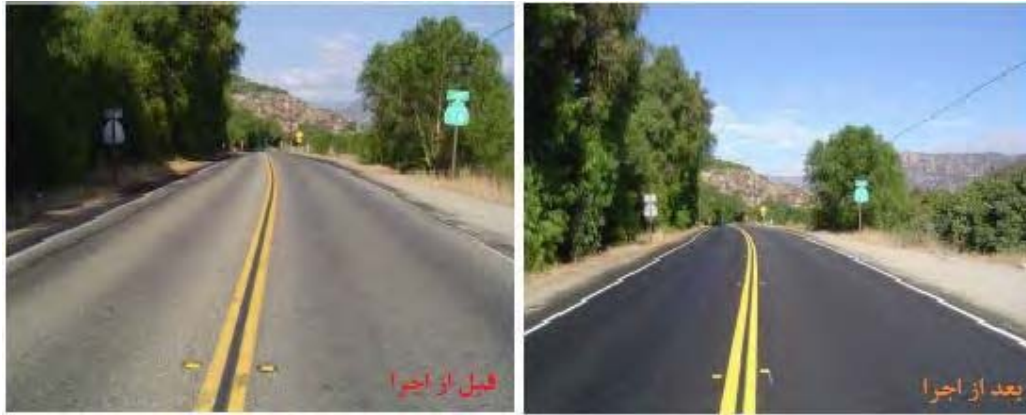
شکل ۸ قبل و بعد از اجرای لایه حفاظتی میکروسرفیسینگ (Rezai .et al, 2017)
