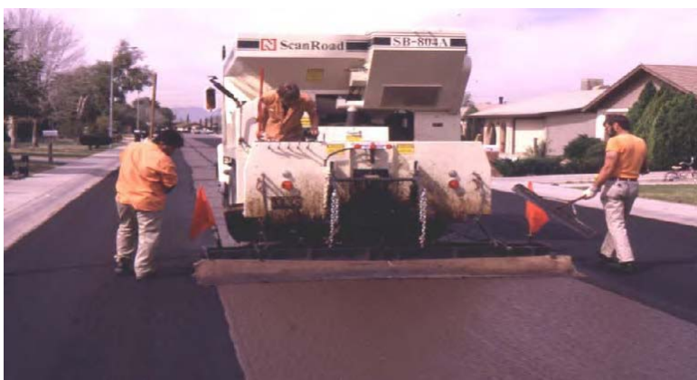
شکل ۵. نمونه‌ای از اجرای اسلاری سیل در مناطق شهری بر روی روسازی موجود (Ardakanian and Arezumand and Musavi, 2015)
