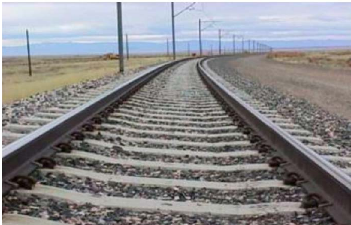
شکل ۴. زیرساخت‌های ریلی شامل، بالاست، پابند و خط آهن (منبع: FRA)
