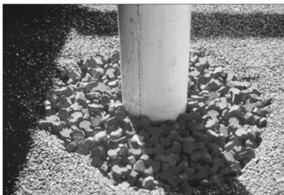
شکل ۶. نمونه توسکان‌های قرار گرفته در کنار یکدیگر برای محافظت از پایه پل (FHWA, 2009)
