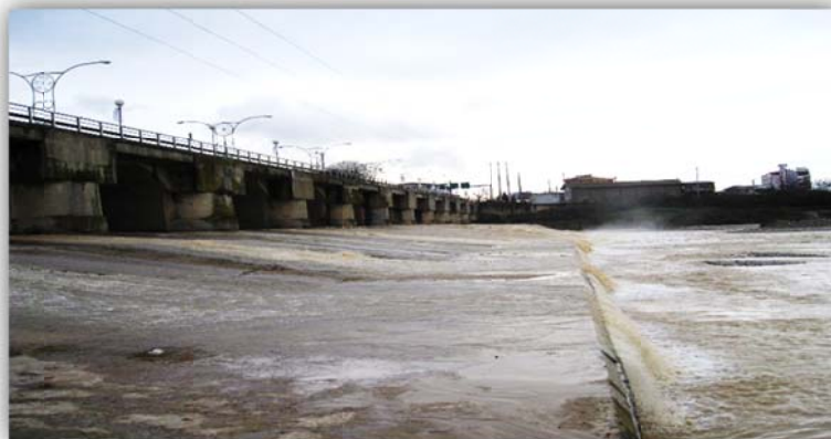
شکل ۱۳. کنترل آبشستگی با احداث رادیه و برید، پل تجن ساری
