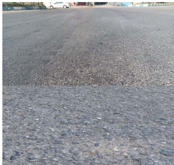
شکل ۱۲. خرابی صیقلی شدن دانه‌ها، (الف) معلم کلا ساری، (ب) مسیر روستایی جنگلی شهید زارع ساری
