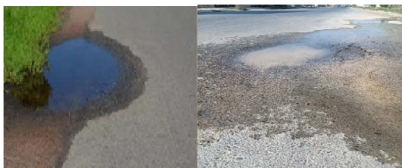
شکل ۷. خرابی ترک خوردگی لبه مسیر جنگلی هزارگریب نکا
