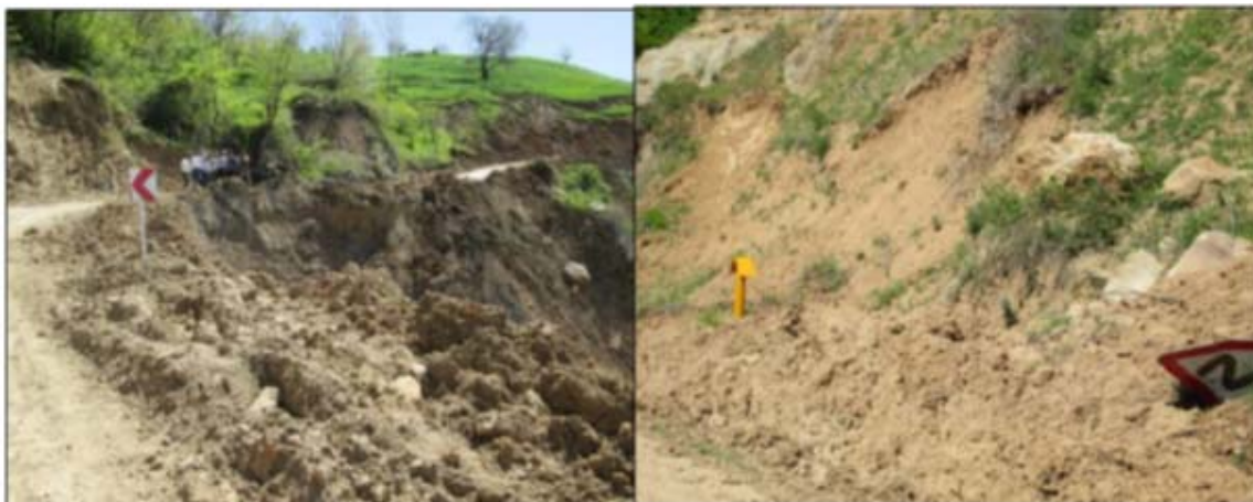
شکل ۴. تخریب بدنه راه در برابر سیلاب (مرکز تحقیقات راه، مسکن و شهرسازی ۱۳۹۸)
