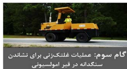
شکل ۳. فرآیند اجرای چپ سیل (Jalali & Vargas-Nordbeck, ۲۰۲۱)
