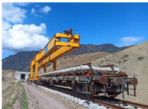
عملیات نصب خط
