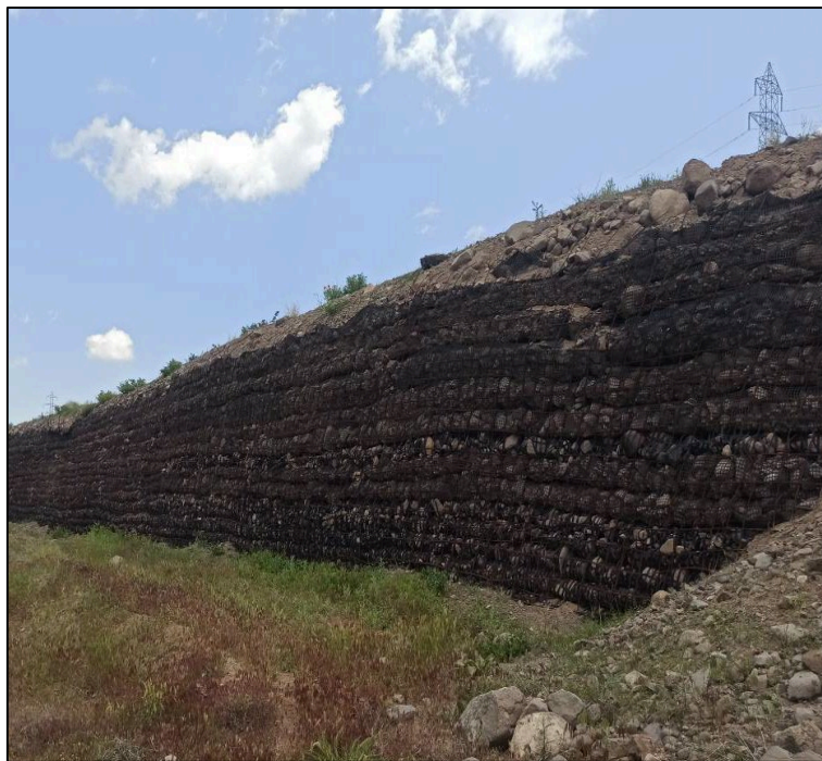
شکل ۱۴. نمای گابیونی دیوار خاک مسلح ژئوگریدی کیلومتر ۳۰۳+۸۰۰
