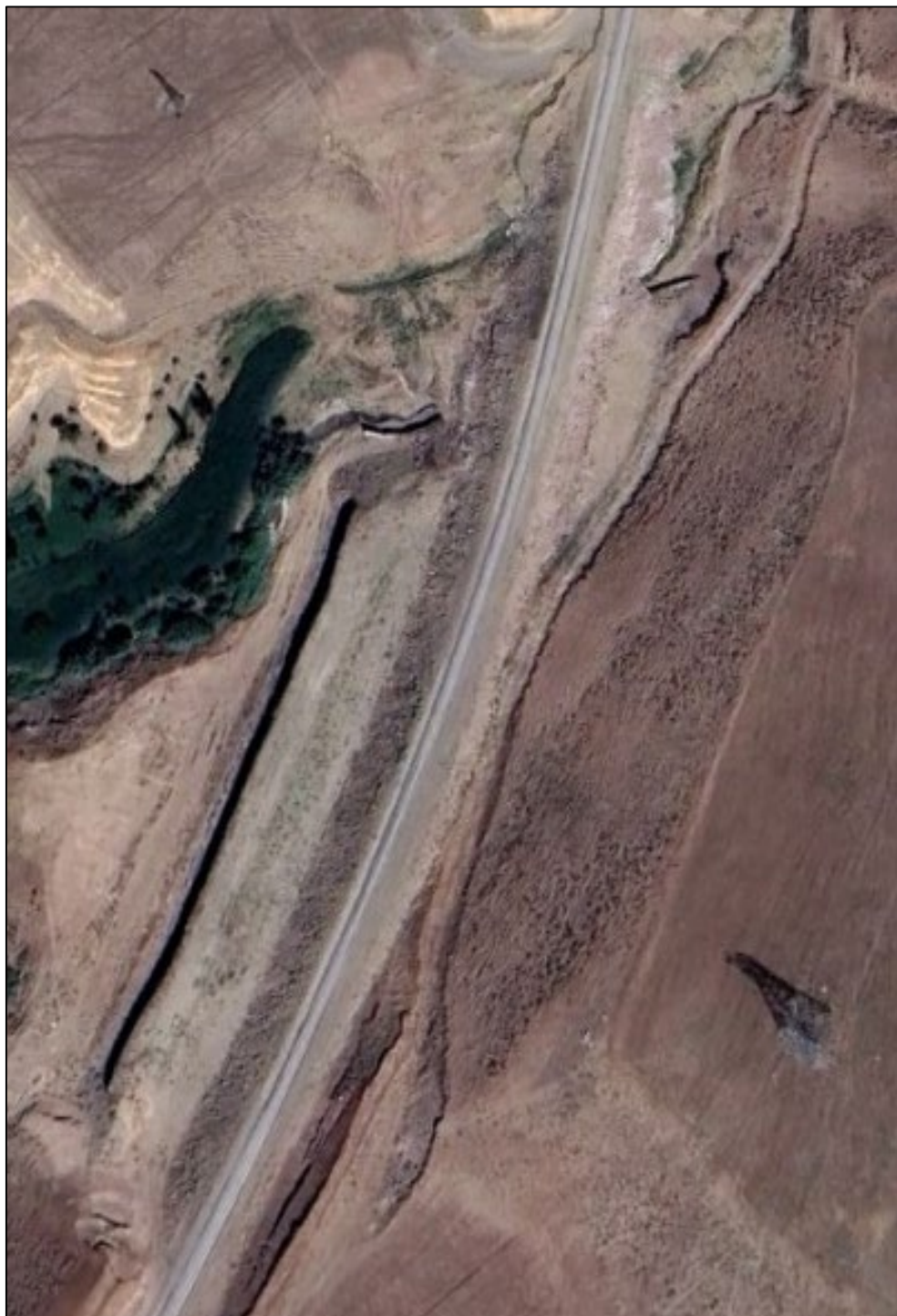
شکل ۱۳. دیوار حائل اجرا شده در مجاورت خاکریز راه‌آهن
