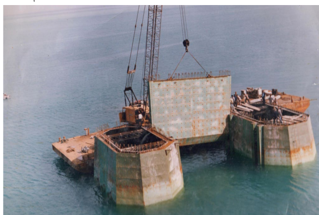
شکل ۵: مدول‌های ساخته شده در حال نصب دیواره آبگیر قشم
