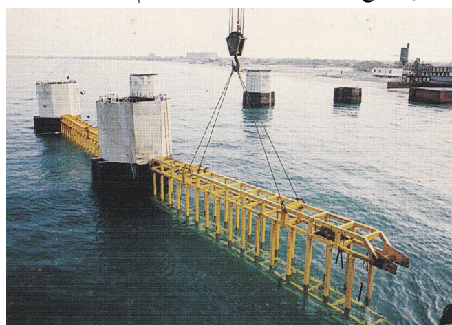
شکل ۷. نصب شابلون‌ها بین مدول‌ها - نمونه موردی اسکله قشم
