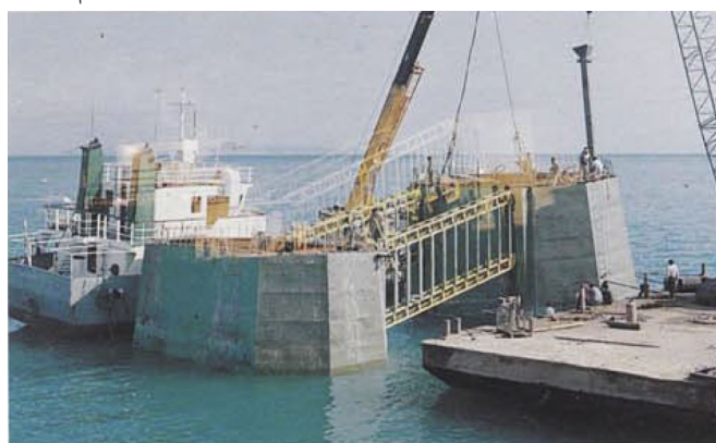
شکل ۸. غرق کردن مدول‌های مجاور با کمک شابلون با بازوهای مفصلی - نمونه موردی اسکله قشم
