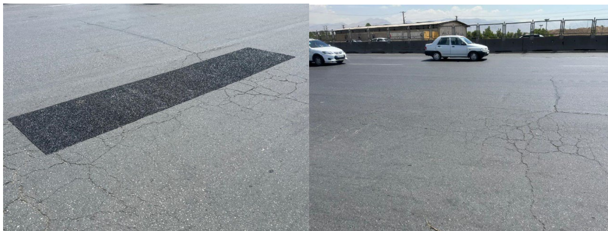
شکل ۶. وضعیت روسازی قبل از اجرا (شکل سمت راست) و بلافاصله بعد از اجرا (شکل سمت چپ) در آزادراه قزوین-کرج
