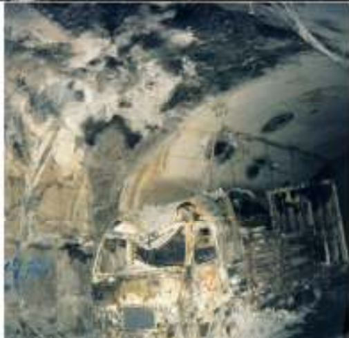
شکل ۱. اثرات بجای مانده از وقوع آتش‌سوزی کامیون در تونل
