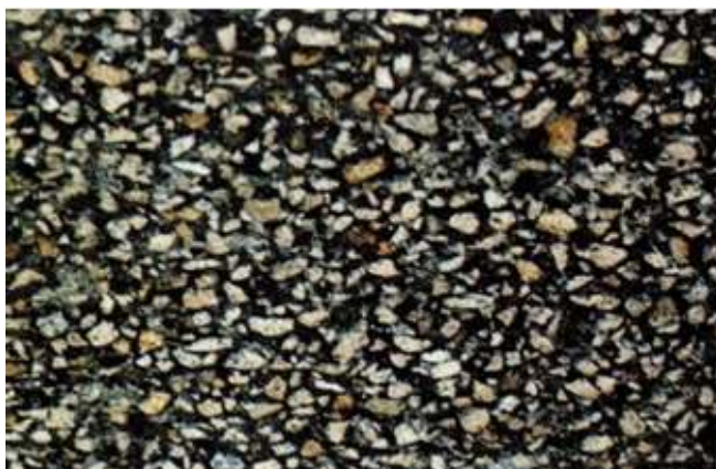
شکل ۱. مصالح سنگی صیقل یافته در اثر جریان ترافیک در طول زمان
