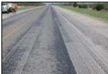
شکل ۹. ایجاد رویه زبر با استفاده از روش تراش سرد یک بافت سطحی در محور طولی جاده
