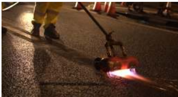
شکل ۱۴. روش کربنیزه یا سوزاندن رویه‌های آسفالتی
