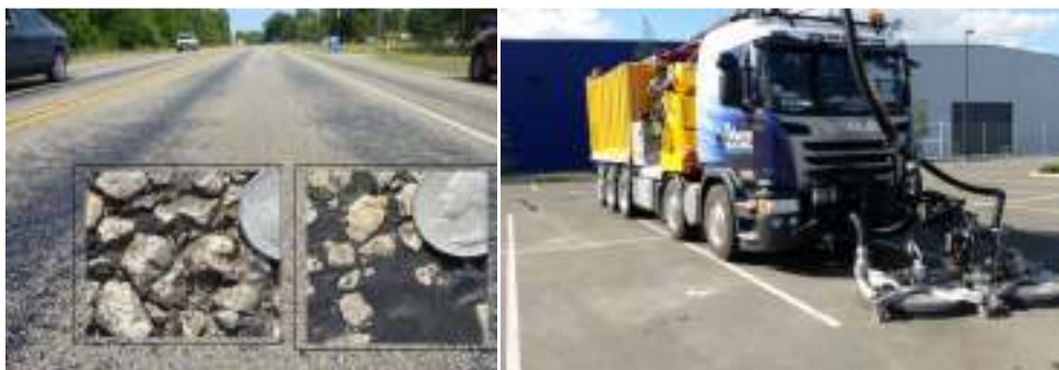
شکل ۵. ماشین احیا سازی رویه صیقل یافته به روش از طریق روش فشار قوی آب
