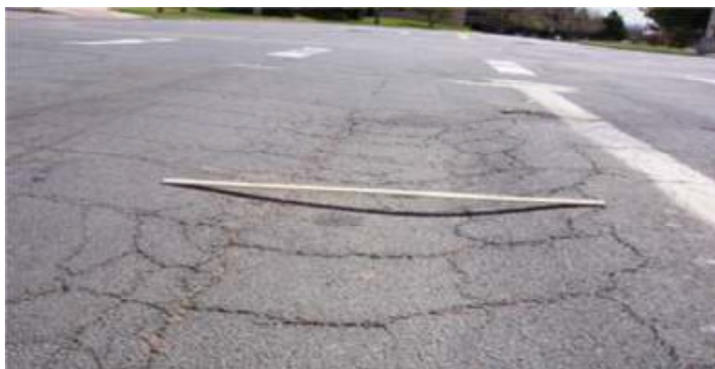
شکل ۳. شیار شدگی رویه‌های آسفالتی
