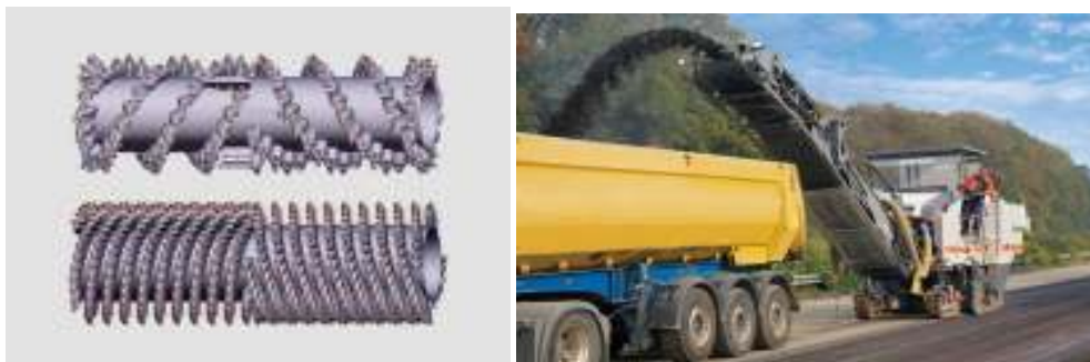
شکل ۸. ماشین احیاسازی رویه صیقل یافته به روش از طریق روش تراش سرد
